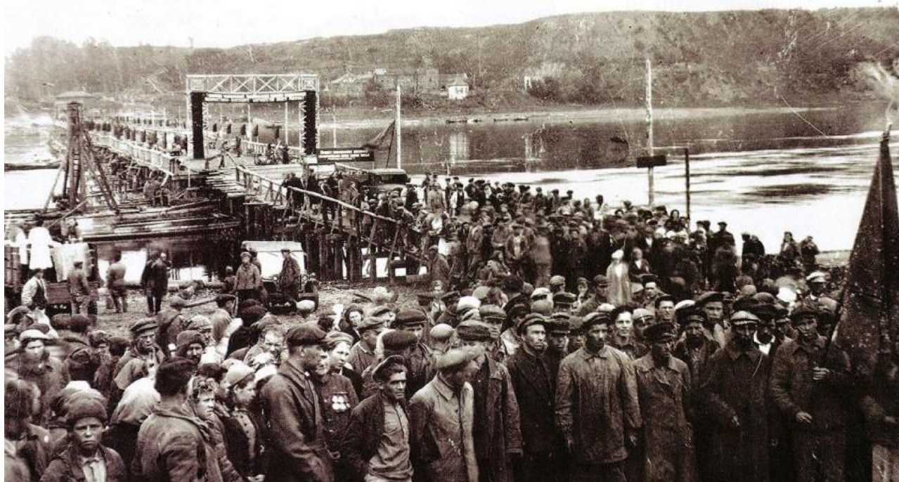
Открытие движения на понтонном мосту через р. Томь, 1946 г.
